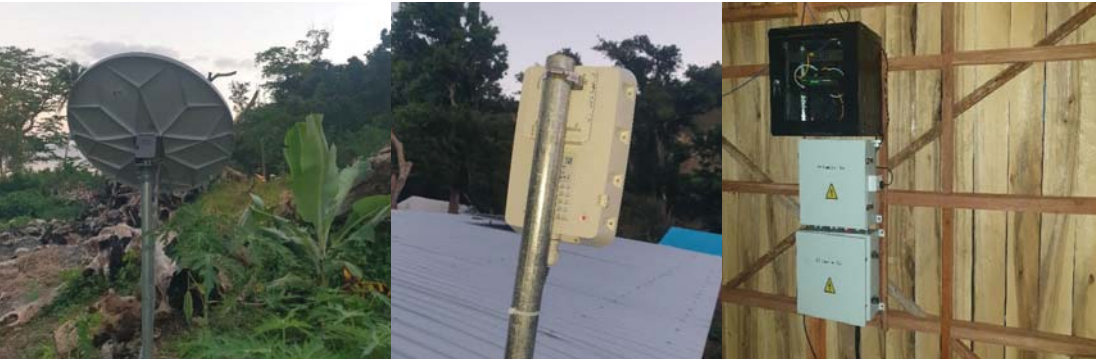
VSAT, équipement d'extension Wifi, batterie solaire et support mural 4RU à la communauté de Punamalah, au nord d'Erromango
